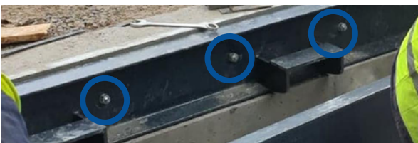
Montaż konstrukcji stalowej za pomocą kotew rozporowych
